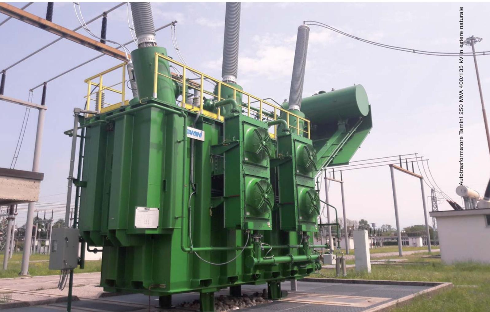
Autotrasformatore Tamini 250 MVA 400/135 kV in estere naturale
